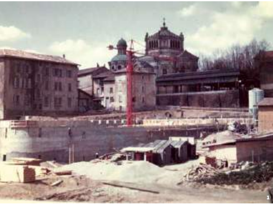
1 à 4. Photographies de chantier. © Archives du sanctuaire d'Ars
